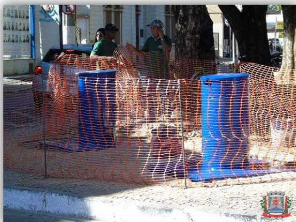
A Prefeitura iniciou a instalação de 08 lixeiras subterrâneas na Praça São Januário
