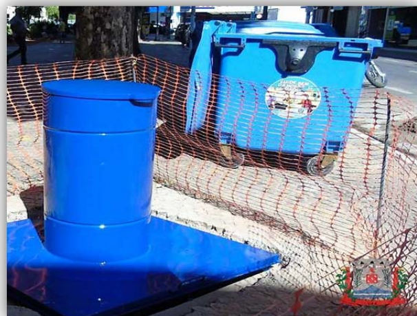
Projeto de instalação das lixeiras subterrâneas visa a substituição dos containers plásticos e diminuição dos impactos causados pelo derramamento de lixo
